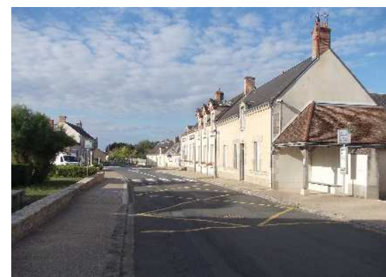
Alignement du centre bourg de Germigny-des-Prés.
