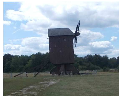
Moulin à vent de Bel-Air
