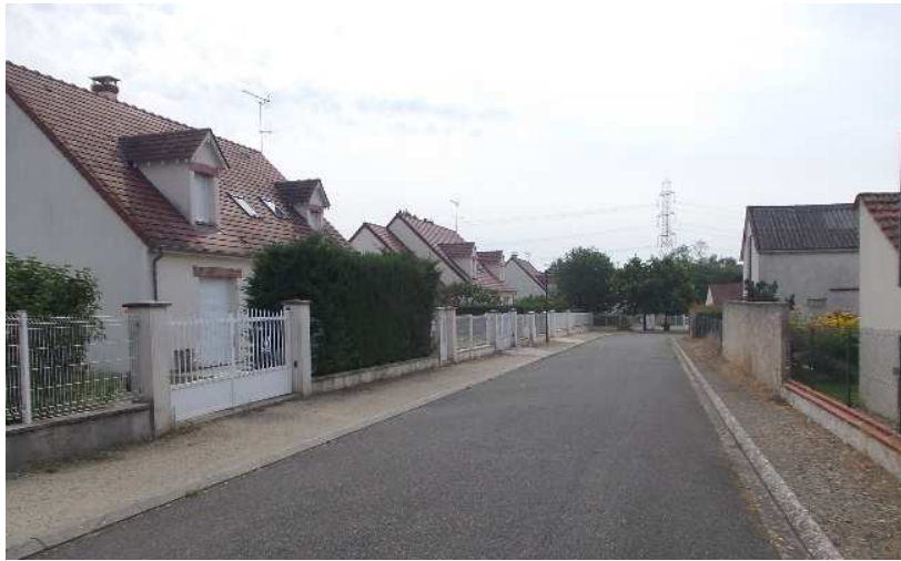
Les Bordes, pavillons utilisant des éléments de l'architecture traditionnelle.
