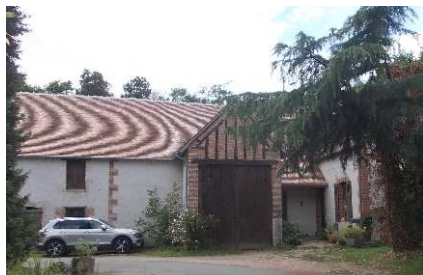
Grange à auvent à Saint-Aignan-le-Jaillard.
