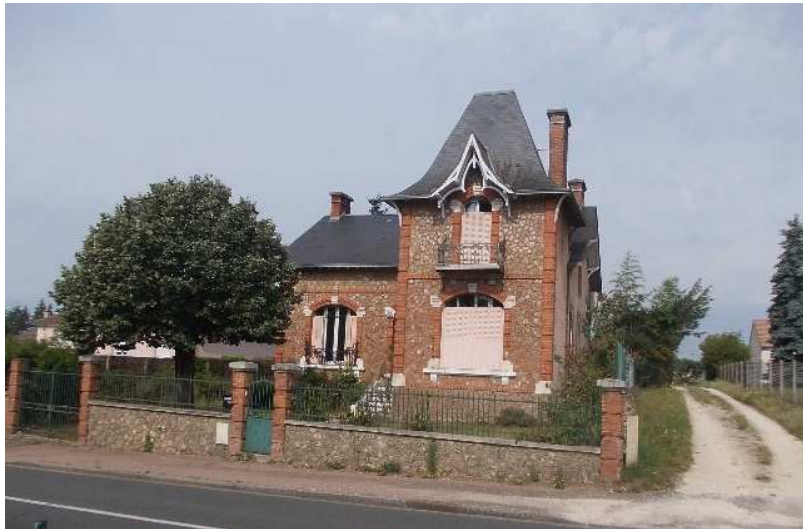
Les Bordes, construction en meulières de la première moitié du 20 ème siècle.
