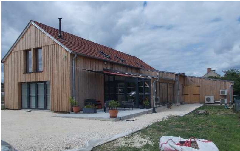
Lions-en-Sullias, modification récente d'un bâtiment existant.
