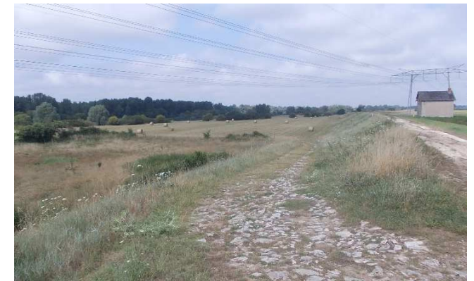
Ouvrage de la levée à Ouzouer-sur-Loire.
