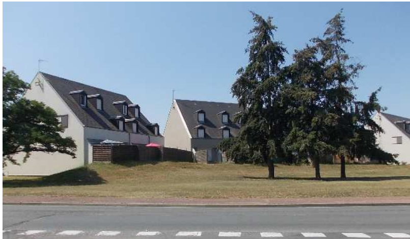
Opération d'aménagement à Sully-sur-Loire regroupant de l'habitat groupé.
