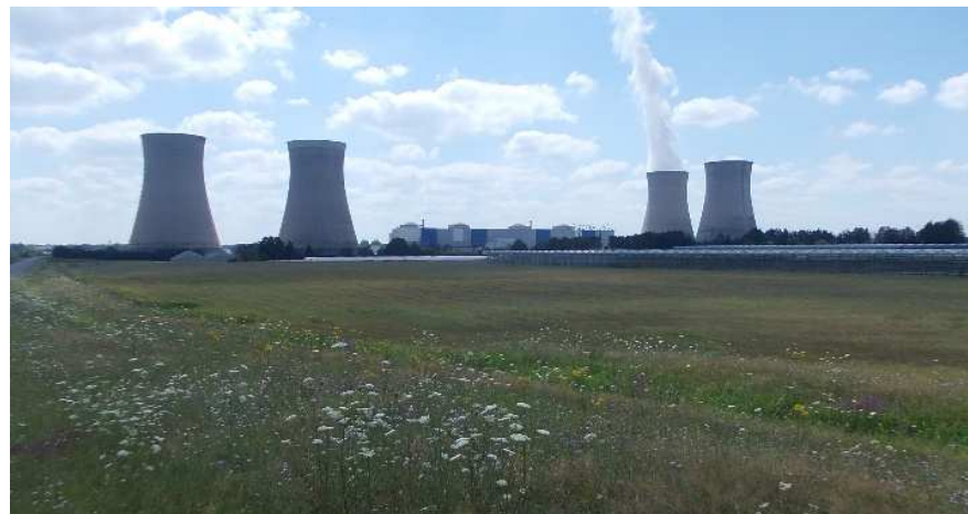
La centrale de Dampierre-en-Burly avec des serres en premier plan.
