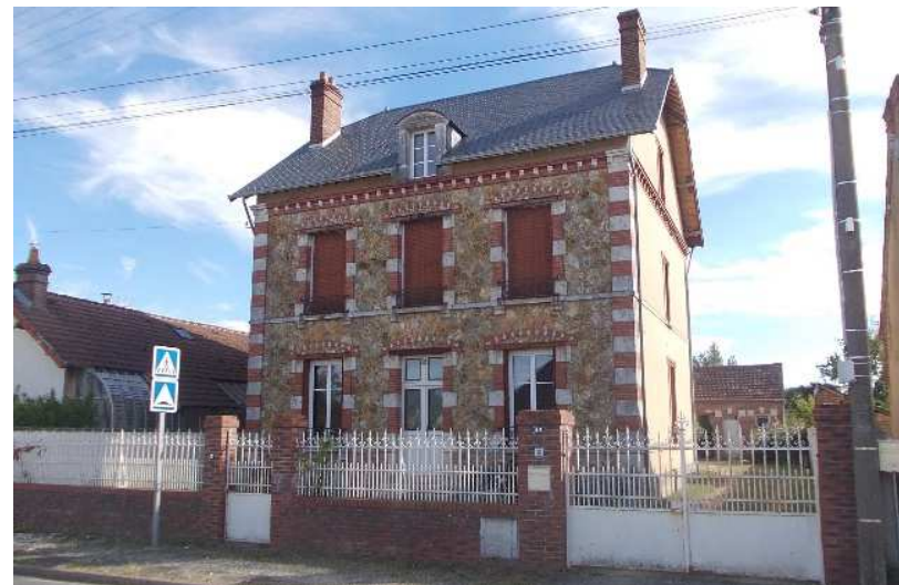
Cerdon construction avec linteau métallique.
